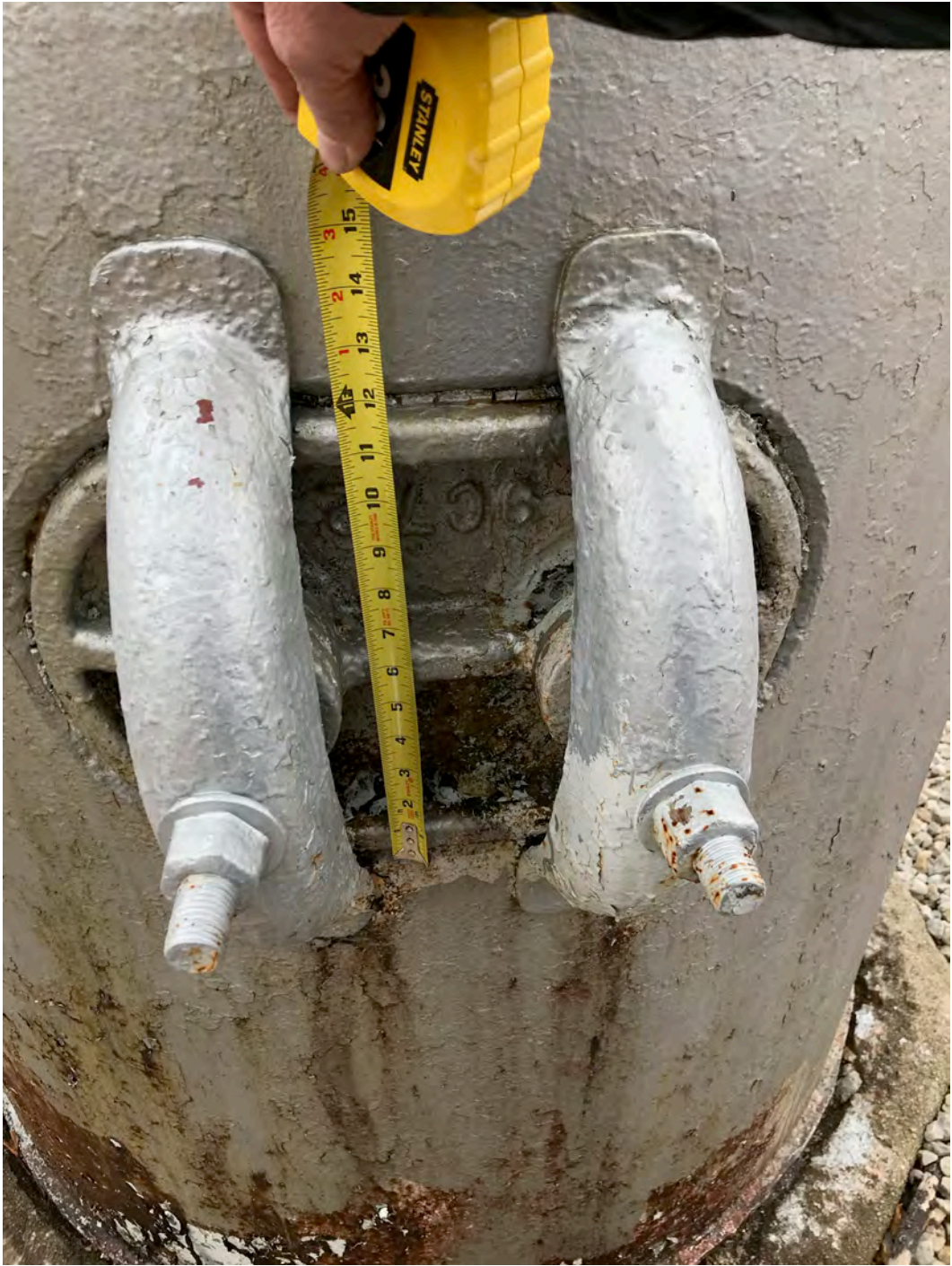
HAER No. IL-1201-29: Riser hatch
