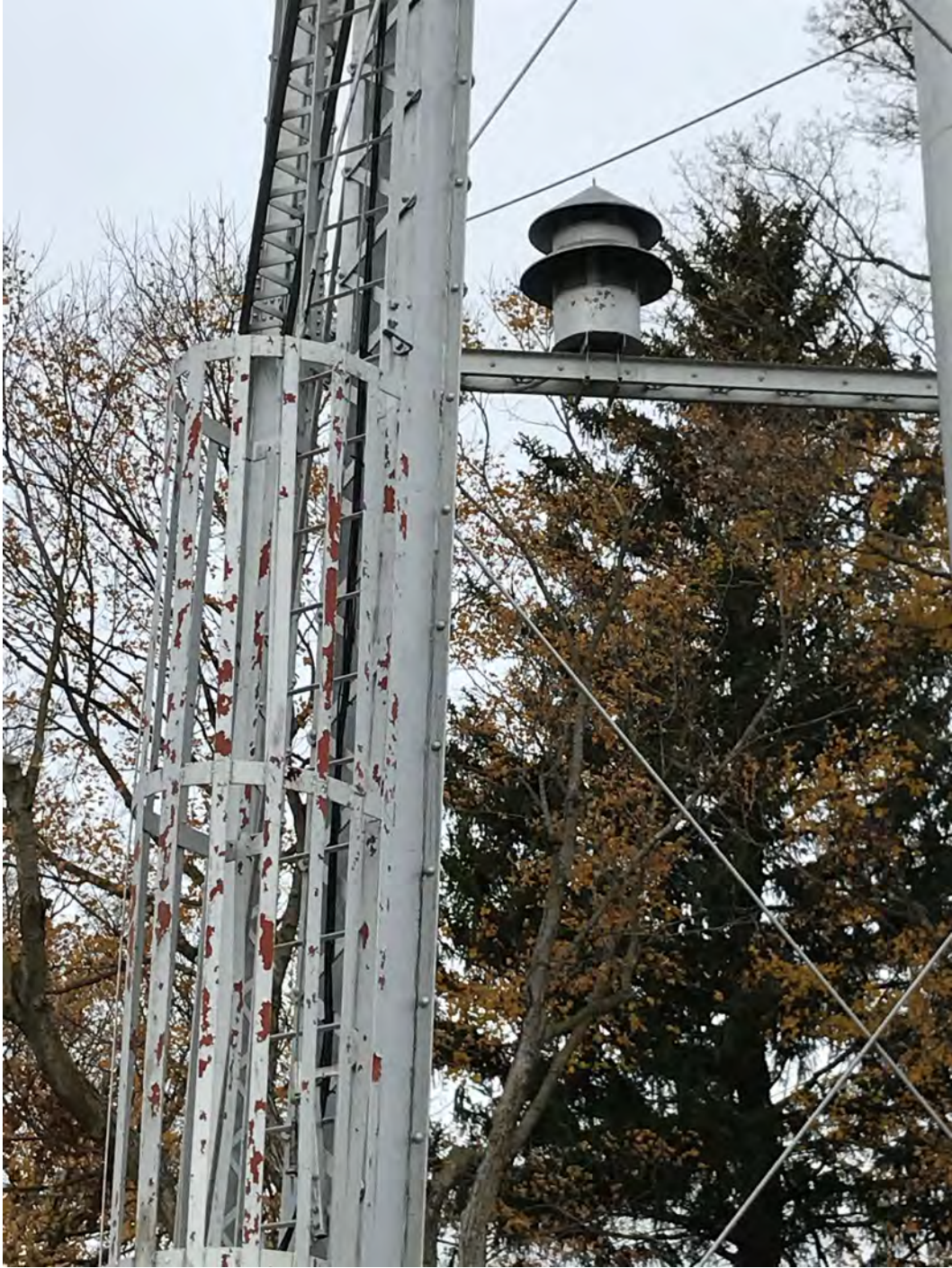
HAER No. IL-1201-31: Siren on strut
