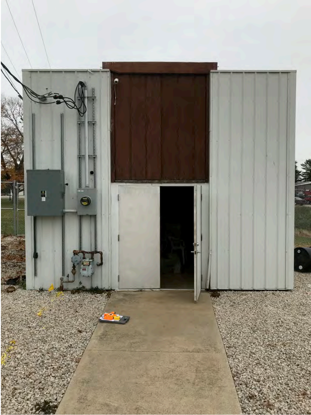
HAER No. IL-1201-13: Pumphouse
