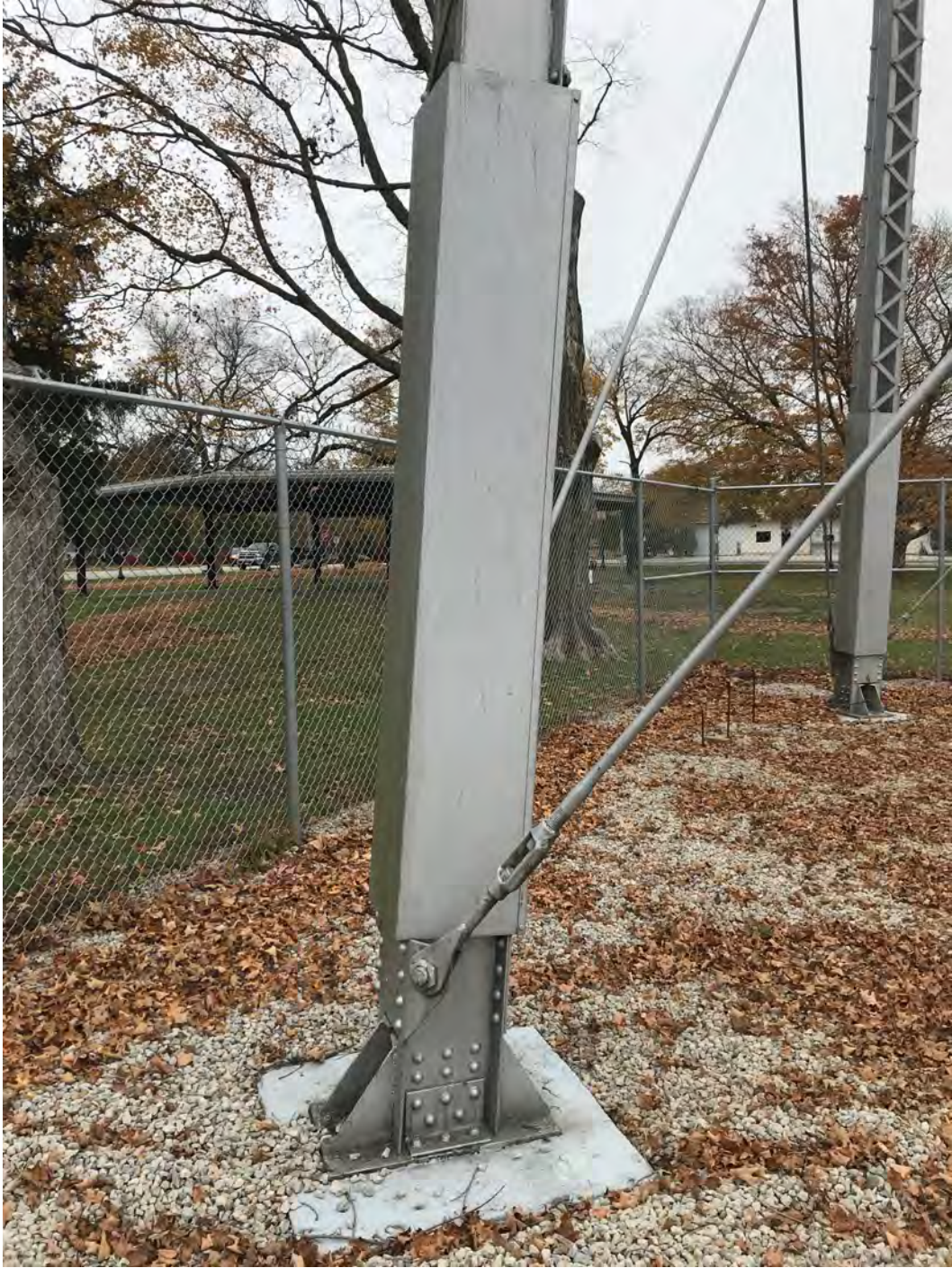
HAER No. IL-1201-27: Column guard
