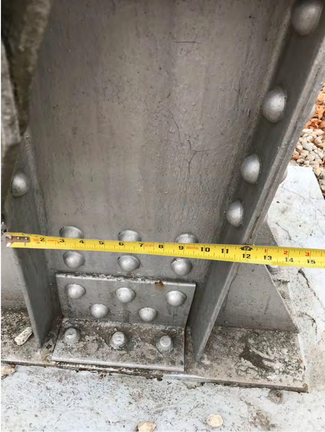
HAER No. IL-1201-20: 12" Column
