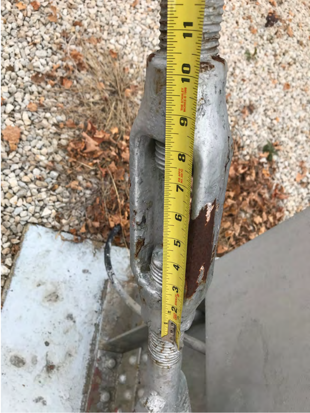
HAER No. IL-1201-19: 10" Turnbuckle
